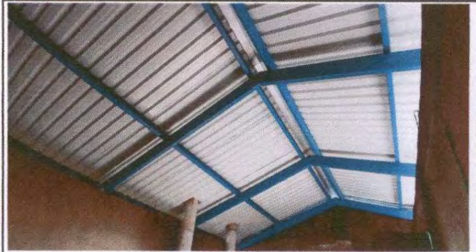
Foto 2: Sustrucción de soporte de madera, por metal
