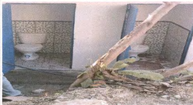
Foto 3: 6.4 Reparación de piso cerámico
