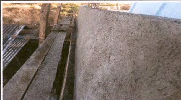
Foto 2: 21.1 Repello en muro
