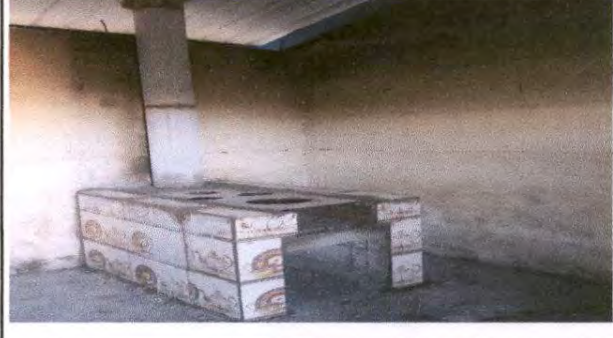
Foto 4: 20.7 Instalación de azulejo en estufa rural
