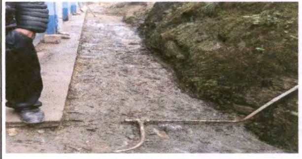
Foto 6: 8.2 Reparación de banquetas de concreto
