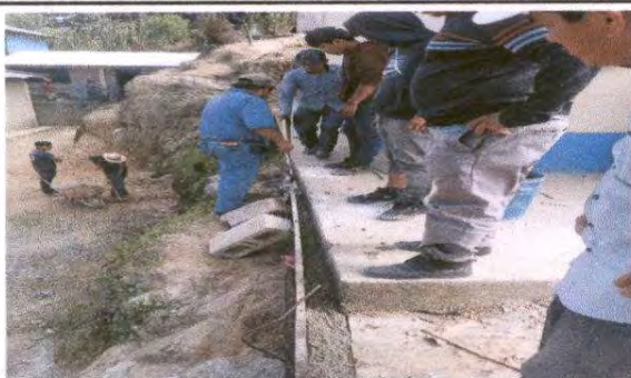
Foto 1: 14.4 Sustitución de tubería PVC línea principal aguas pluviales
