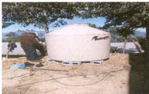
Foto 5: 18.3 Sustitución de depósito de agua 1700 lt
