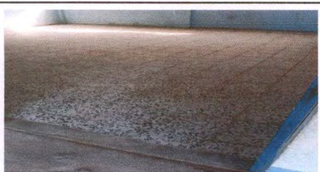
Foto 5: Sustrucción de piso granito en aula Módulo 1
